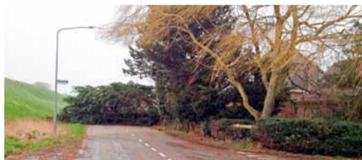
Tijdens de storm van vorige week was er schade langs de Dijkweg, hoek Palingpadje Foto: Hessel de Greeuw
