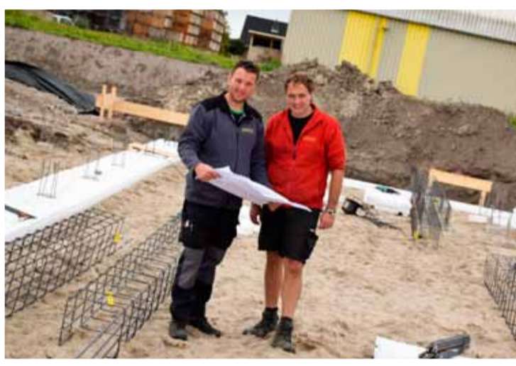
Eigen huisvesting voor onze Poolse medewerkers is in aanbouw.
